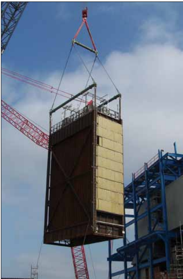
75 Ton Module Lift
